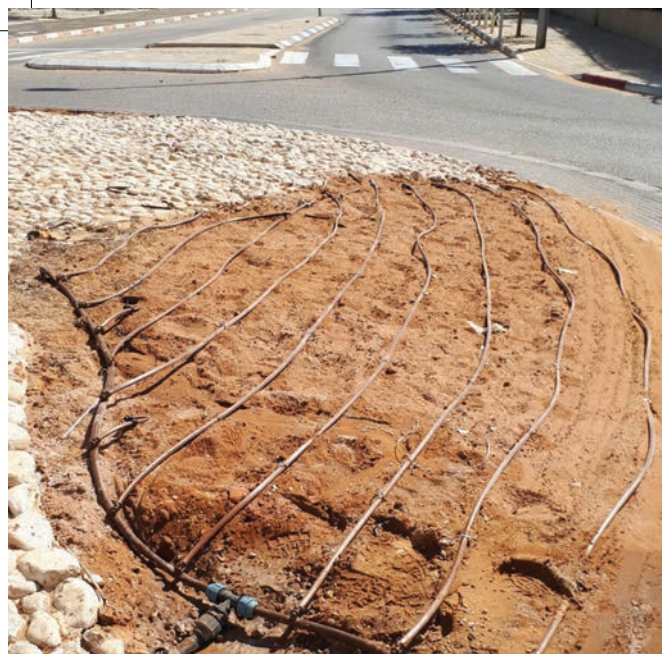
תל אביב: מערכת מותקנת לפני כיסוי/הנחת מרבד הדשא
