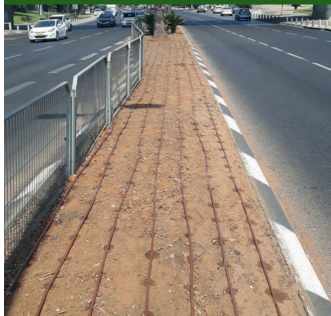
תל אביב: בדיקת מערכת בלחץ לפני כיסוי/הנחת מרבד הדשא
